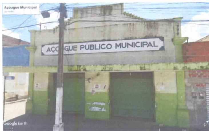
Figura 2 – Fachada da Edificação
